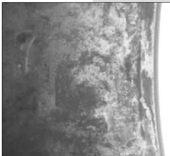
图 47. 配合不当造成了典型的磨擦腐蚀。轴承及其底座在承载负荷的情况下发生相对位移，导致了这一磨损和腐蚀的产生。
